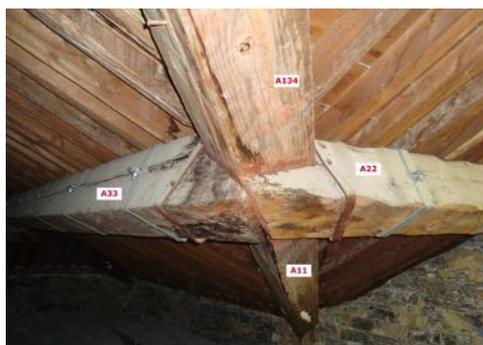
Fig. 1 - Ammaloramento travi
