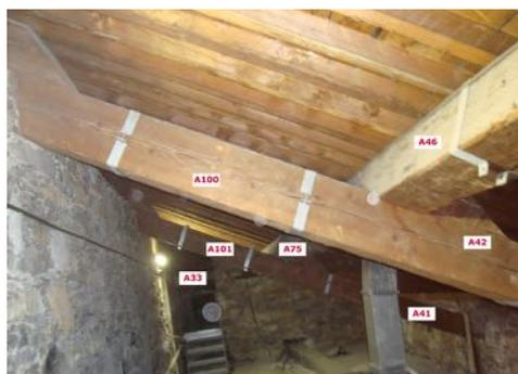
Fig. 2 - Stato fessurativo travi
