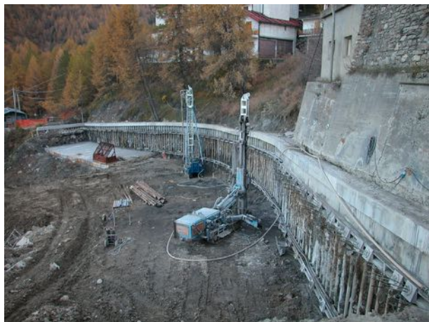
Fig.2 - Realizzazione palificata
