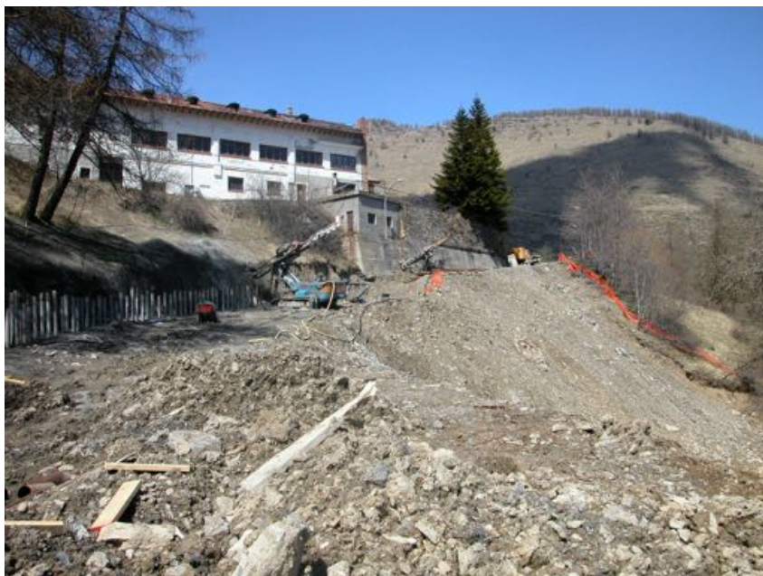
Fig.1 - La zona prima dell'intervento
