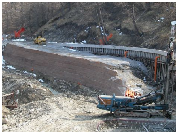
Fig.4 - Realizzazione di terra armata
