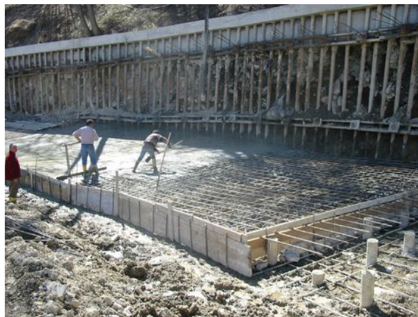
Fig.3 - Realizzazione di platea su terreno bonificato
