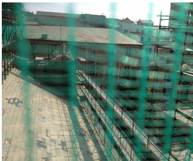
Fig. 3 - Esecuzione dei ripristini sulla copertura
