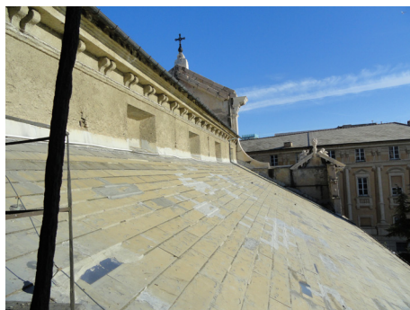
Fig. 1 - Vista della copertura della Cattedrale
