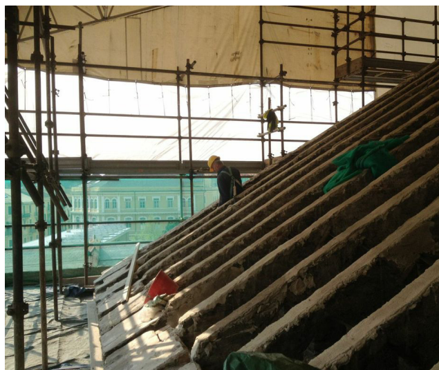
Fig. 4 - Lavori di ripristino sulle travi di copertura
