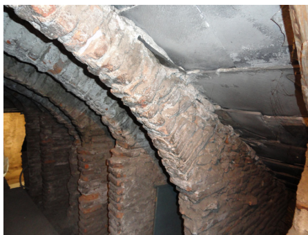
Fig. 2 - Vista delle strutture in muratura
