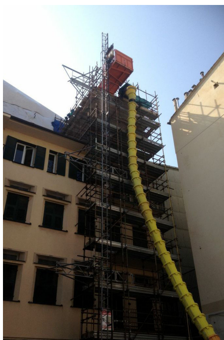
Fig. 5 - Vista del cantiere
