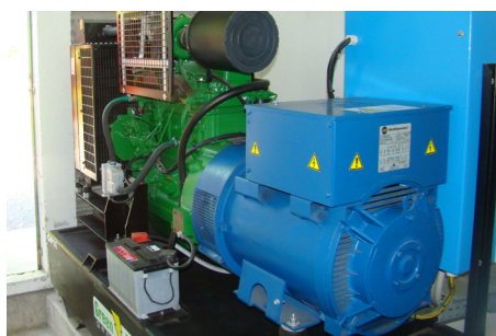
Fig. 3 - Gruppo elettrogeno galleria Montegrosso
