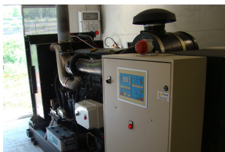
Fig. 2 - Gruppo elettrogeno galleria Pieve di Teco
