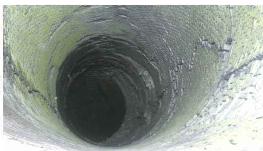
Fig. 3 - Il camino, causa del dissesto
