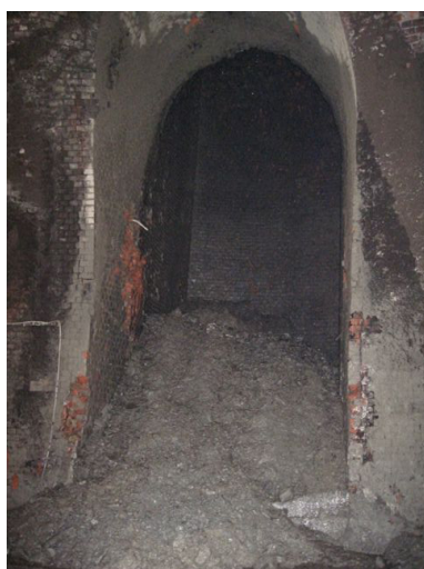
Fig. 1 - Lo stato dei luoghi a seguito del dissesto
