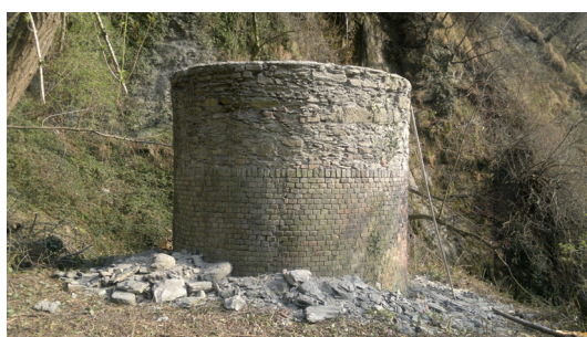
Fig. 2 - Il camino, causa del dissesto
