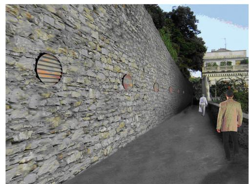
Fig.8- Foto del paramento del muro come si presenta prima del consolidamento e simulazione dell'opera terminata con in vista gli alloggiamenti dei tiranti
