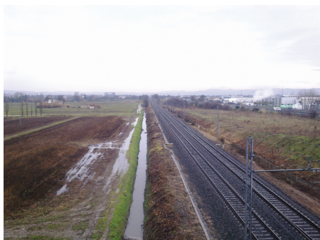
Fig.1 - Vista della linea ferroviaria e del tratto allagato
