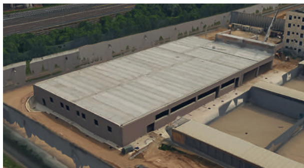
Fig.7 - Edificio in costruzione
