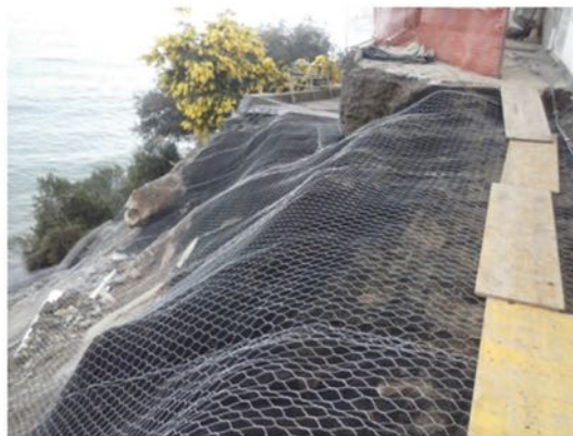
Fig.7 - Stesura delle reti per il rafforzamento corticale
