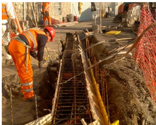
Fig.6 - La palificata di monte: orditura del cordolo testa-pali
