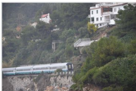
Fig.1 - Stato dei luoghi a seguito dell'evento franoso: vista generale
