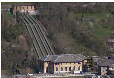
Fig. 1 - Vista d'insieme della centrale
