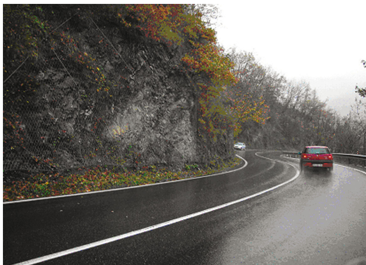
Fig. 1-2-3 - Alcune foto del tratto della Strada Statale 28 che sarà interessato dall'intervento di rettifica
