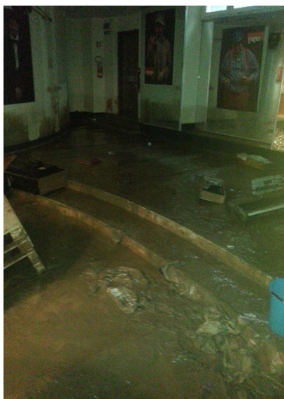
Fig. 2 - Piano fondi a seguito dell'evento alluvionale
