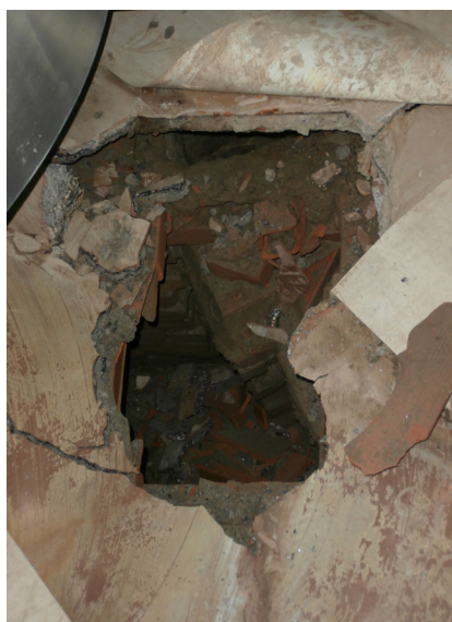
Fig. 1 - Sfondamento del solaio causato dalla sotto-spinta idraulica
