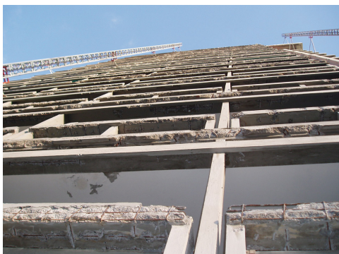
Fig. 1-2 - Alcune foto dell'edificio prima e durante i lavori.
