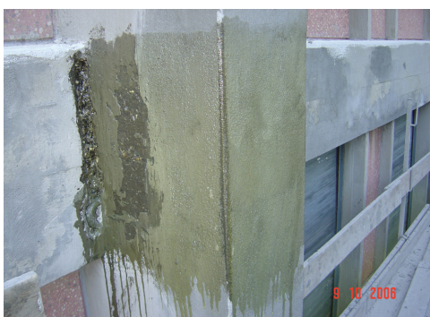
Fig. 3-4 - Dettagli preparazione e messa in opera rinforzi in carbonio
